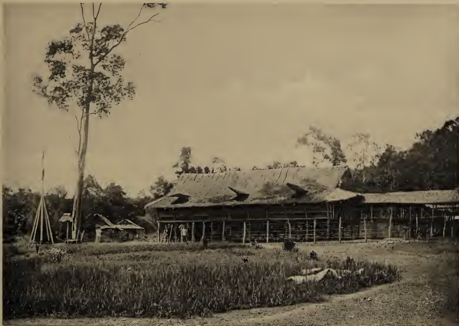
Afb. 268. De Controleurswoning (tijdelijk verblijf) te Lōlōwa s u.
